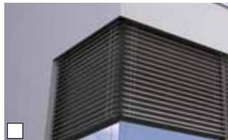
Mit Gehrungsecken (gesägt) lassen sich Eckverbindungen perfekt realisieren.
